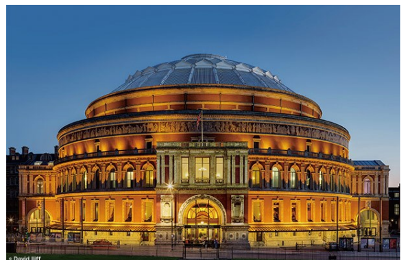
ロイヤル・アルバートホール
